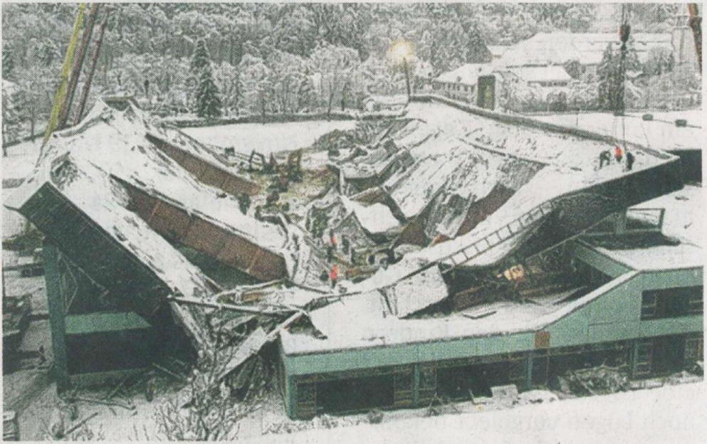
Die Trümmer der Eissporthalle von Bad Reichenhall. Das Dach war am 3. Januar 2006 unter der Schneelast zusammengebrochen. Foto: AP
